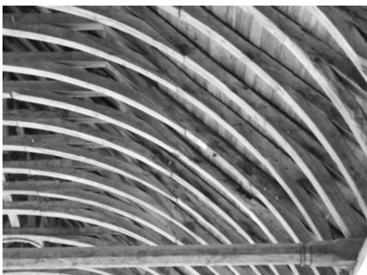
La robuste charpente du dortoir en nef de bateau renversé.
