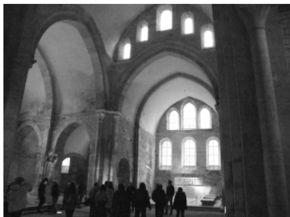
les voûtes de l'église.
