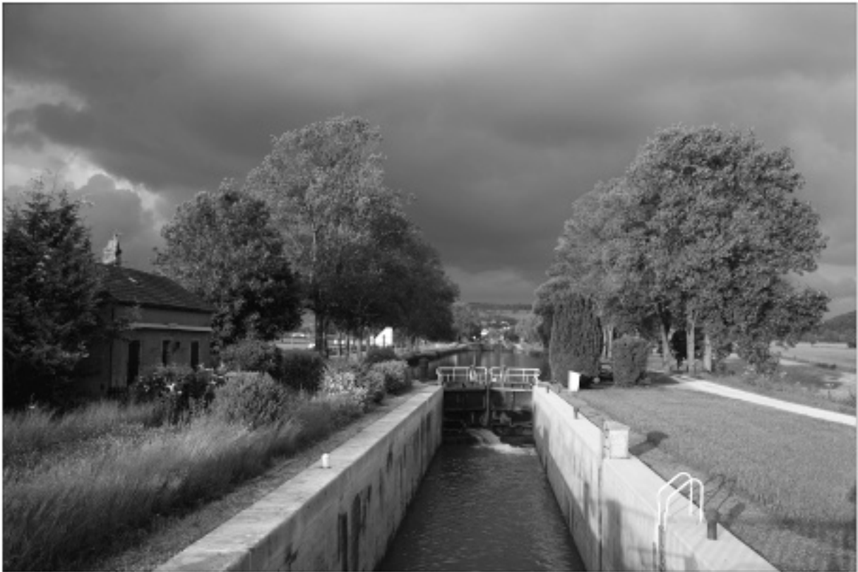
Soirée d'orage sur l'échelle d'écluses de Pouilly. Afin de redescendre dans le bassin de l'Armaçon, le canal est équipé de 6 écluses rapprochées que l'on appelle "échelle". Bordée de frênes, elle constitue un bel alignement !
