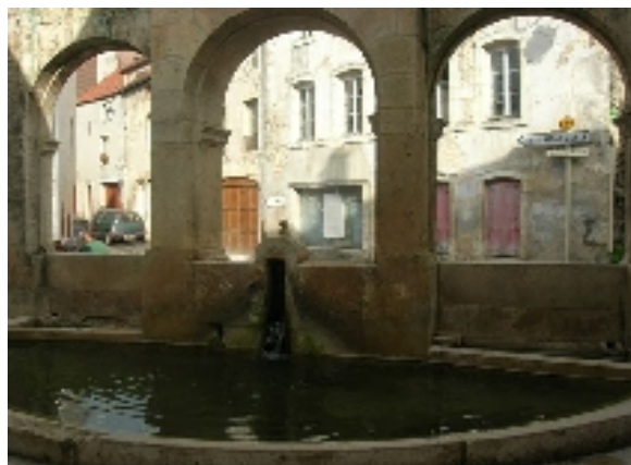
Le lavoir de Saint-Seine-l'Abbaye vu de l'intérieur
